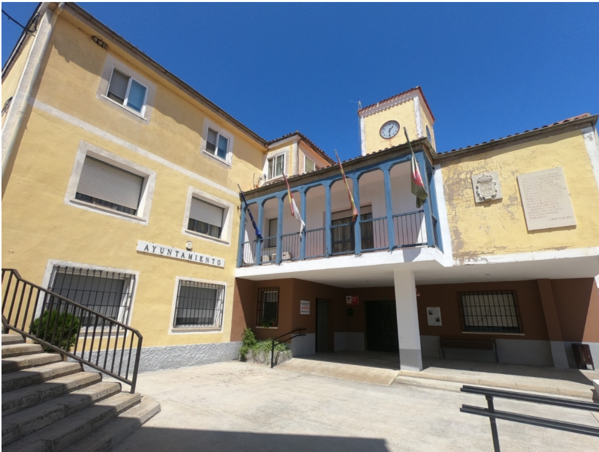
Fachada del Ayuntamiento de Carboneras de Guadazaón, Cuenca. (Foto: Lifecuenca)
